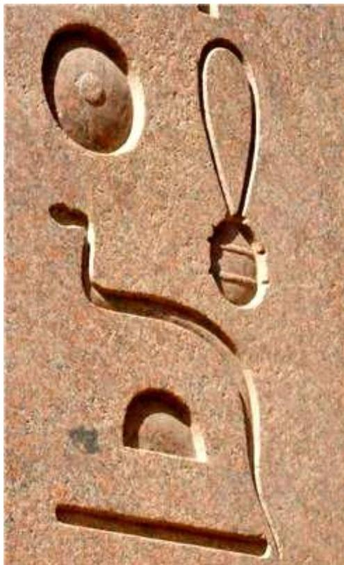
Рисунок 12 Объемная гравировка на шлифованной плите из гранита
